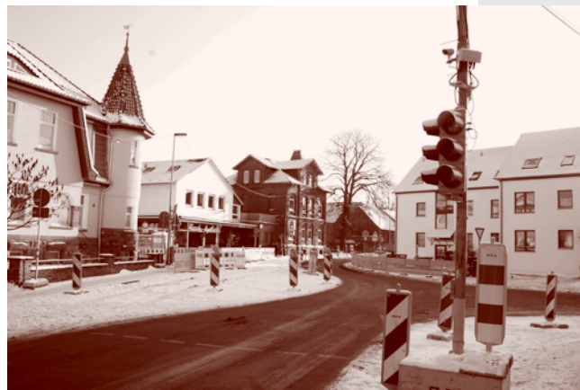
Kanalisationsarbeiten auf der Heerstraße
